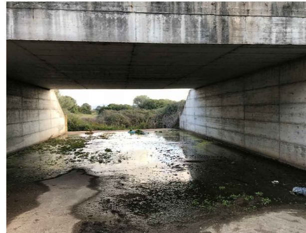
Foto 1 _ Attraversamento Via De Nicola _ da monte
