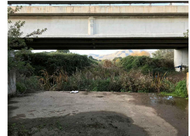
Foto 2 _ Attraversamento Circonvallazione Ovest _ da valle
